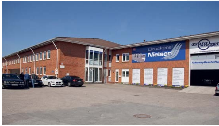
1.400 m 2 Platz bietet das 2010 bezogene Gebäude der Druckerei Nielsen in der Behmstraße in Flensburg.
